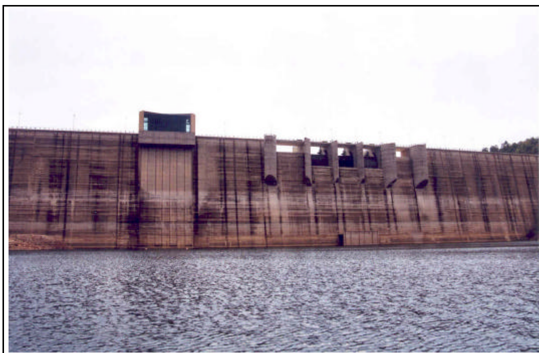
Foto 1. Vista de la presa de Rialb (5-09-2002).
