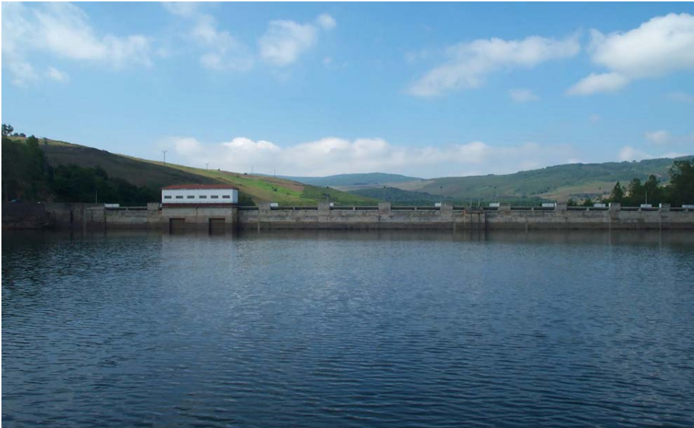
Vista de la presa desde la estación de muestreo (E1). Verano de 2004 (20/07/2004)
