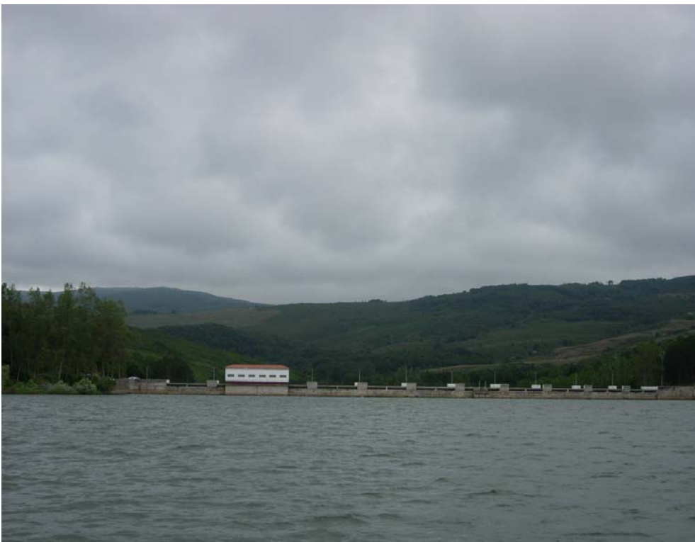
Vista de la presa desde la estación de muestreo (E1). Verano de 2005 (04/07/2005)
