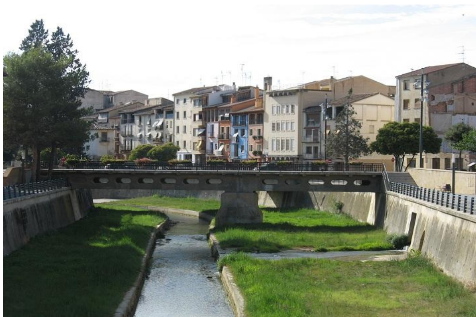
Figura 24-5. Canalización del río Vero en Barbastro.
