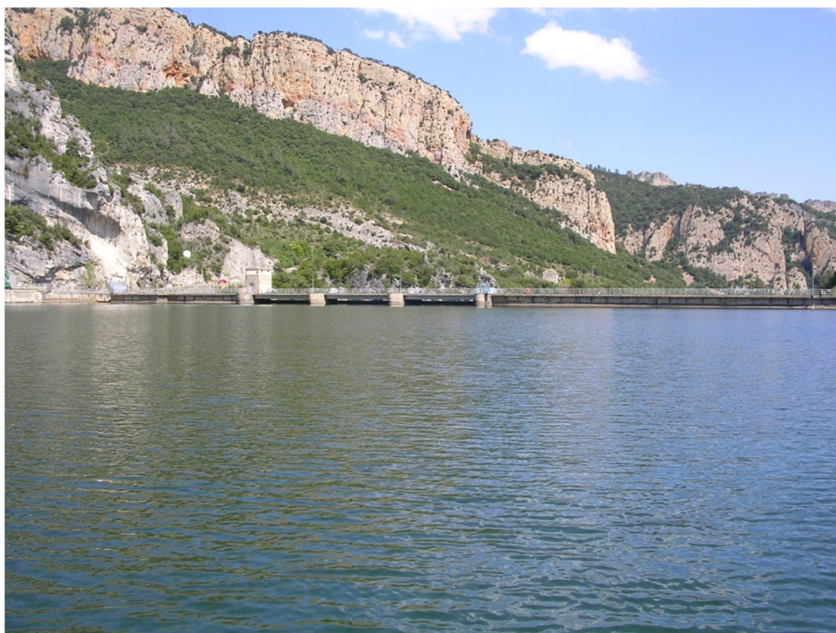
Figura 7. Vista de la presa del embalse
