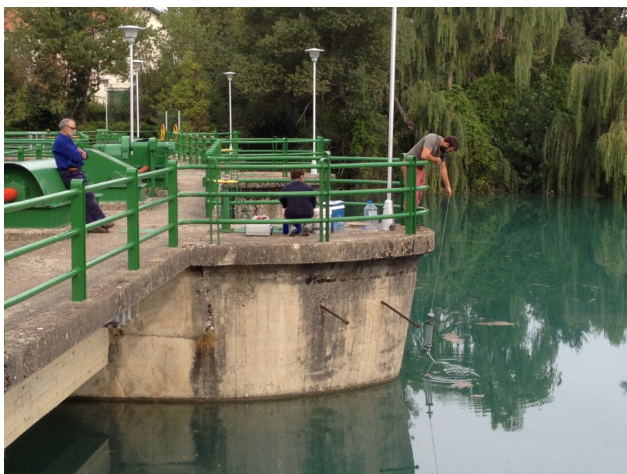
Figura 6. Toma de muestras desde la presa
