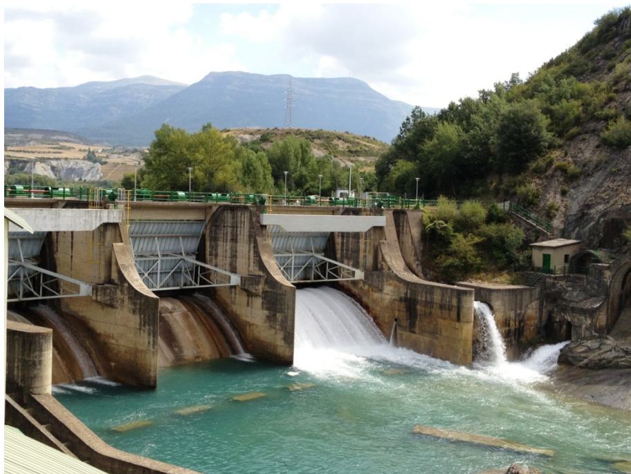
Figura 5. Vista de la presa del embalse
