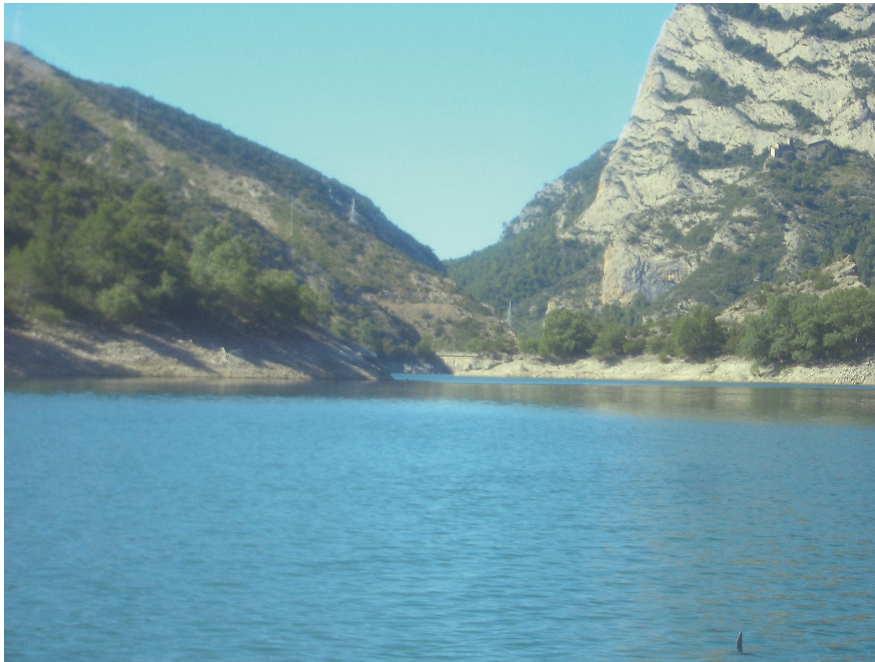
Figura 7: Vista del embalse hacia la presa
