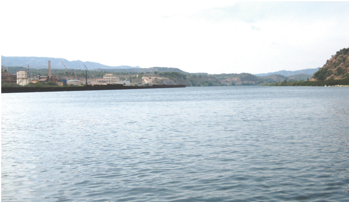
Foto 2: Vista del embalse y la zona de obras
