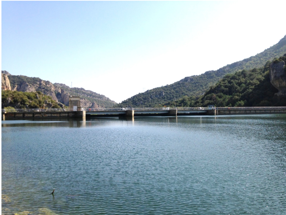
Figura 7. Vista de la presa del embalse.
