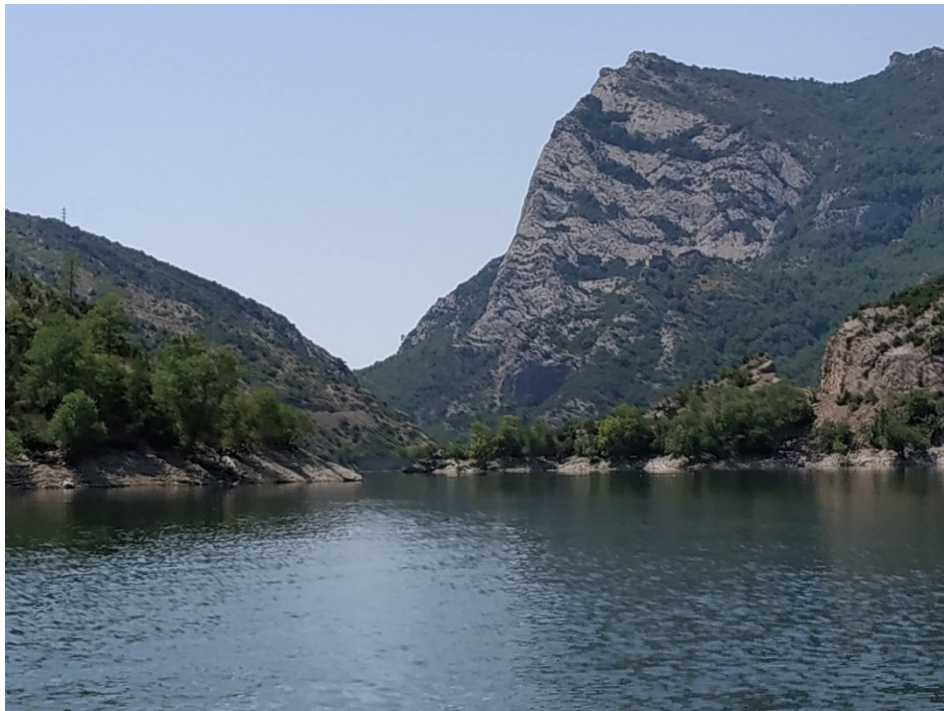
Figura 7. Vista de la zona de presa del embalse
