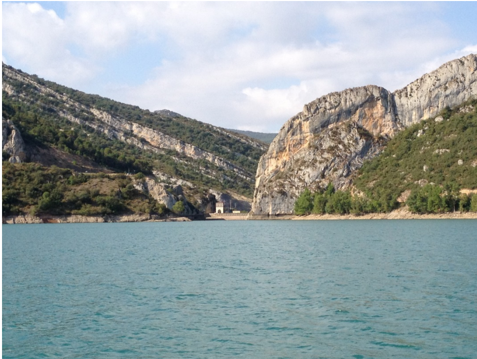
Figura 7. Vista de la presa del embalse
