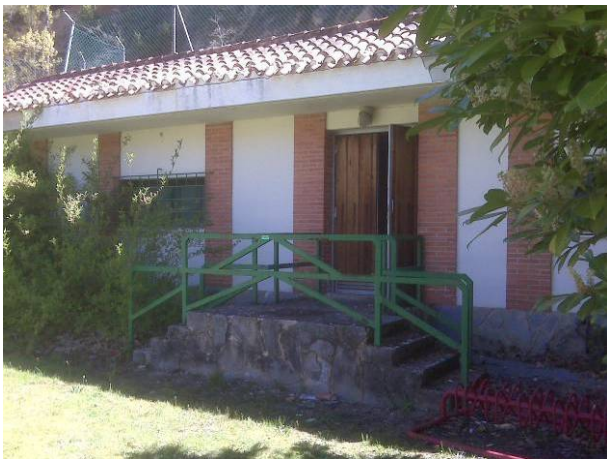
Edificio de la sala de bombas
