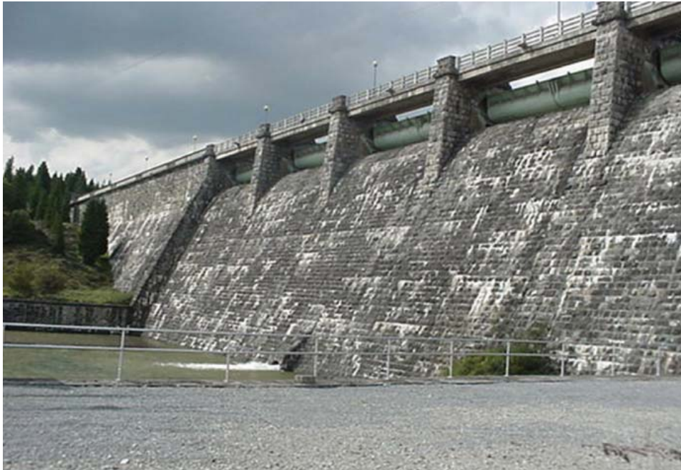
Vista del paramento de aguas abajo. Aliviadero y rápida
