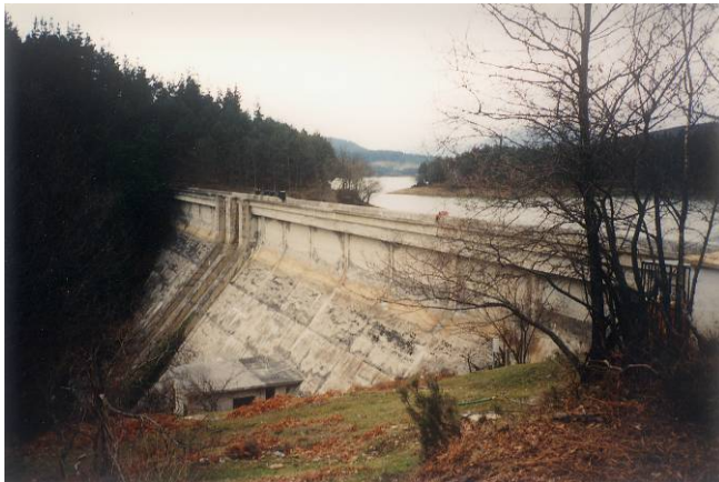
Vista de la presa desde las proximidades del estribo izquierdo
