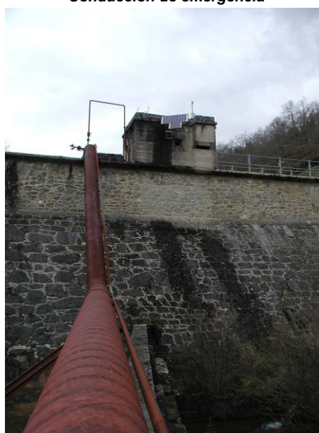
Vista des sifón y caseta desde aguas abajo
