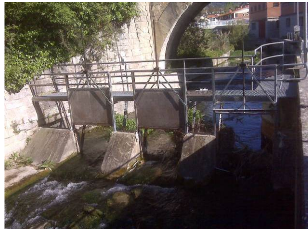
Azud de derivación. En margen izquierda, obra de toma.
