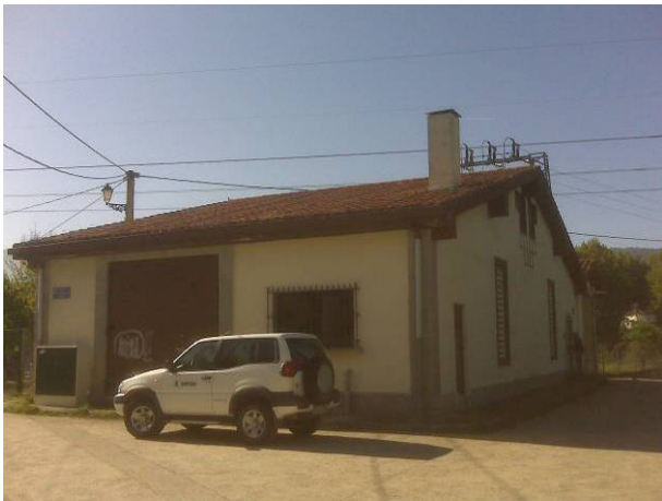
Edificio de la sala de bombas
