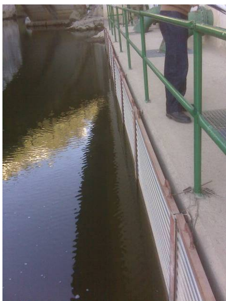
Obra de toma. Rejillas de las cántaras
