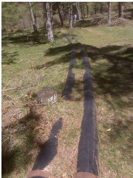
Conducciones de impulsión (2x250mm)
