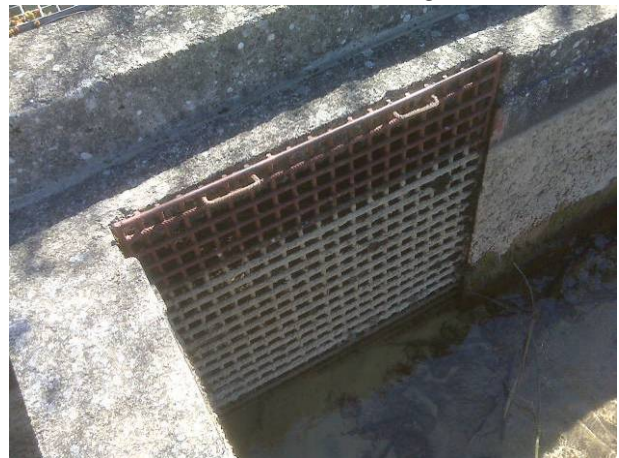
Rejilla de la obra de toma
