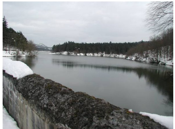
Vista del embalse de Albina desde la coronación de la presa
