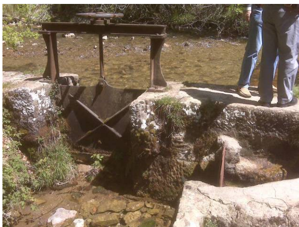
Toma obra de emergencia
