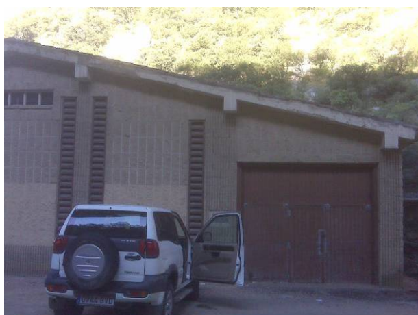
Edificio de la sala de bombas
