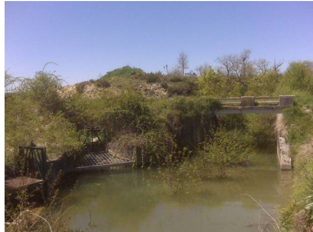
Inicio de la conducción de emergencia
