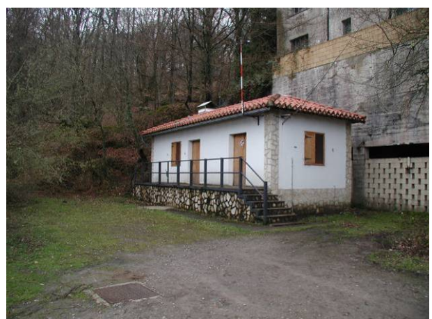
Caseta de cloración
