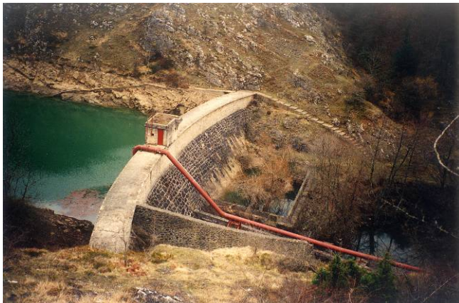
Vista de la presa desde las proximidades del estribo derecho
