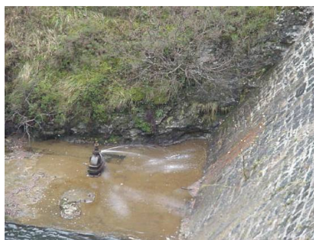
Desagüe de fondo
