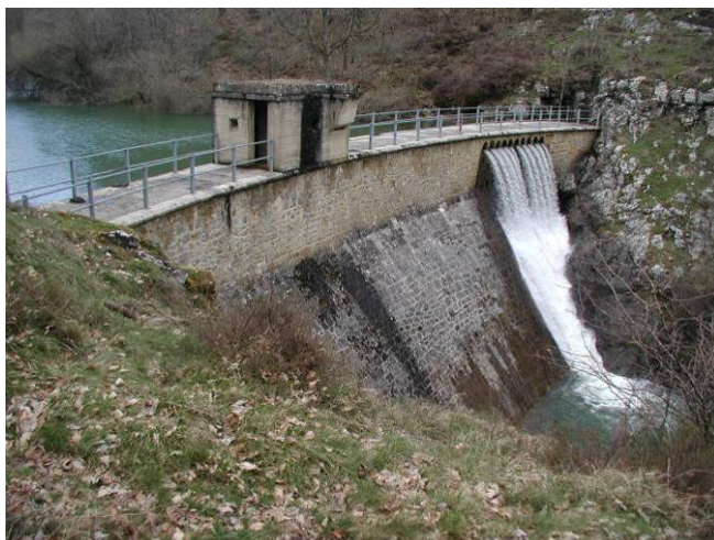
Vista de la presa desde las proximidades del estribo derecho
